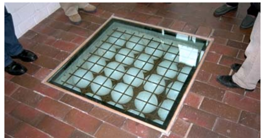
コンクリートを軽くするためボールが入っている
