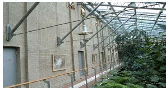
アトリウムに面した壁はレンガ造だが中空になっていて、日射で暖まった空気を室内に放出する
