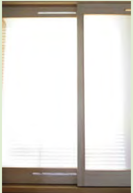
写5 空気循環型断熱戸 上下に通気口が開いている
