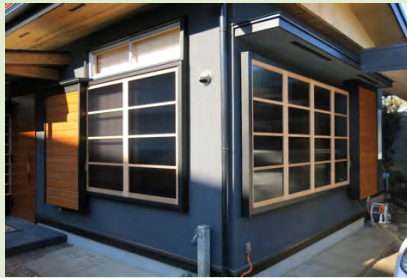
写7 断熱雨戸を閉めた状態（断熱雨戸を閉めても欄間は開放できる）
