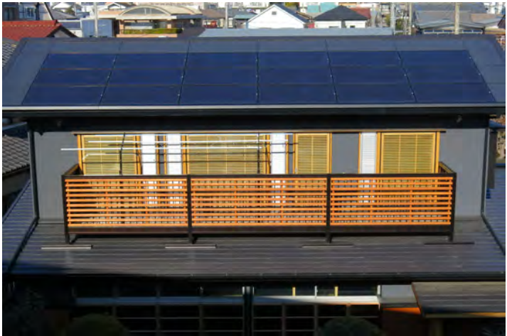
写2 木軸両面ガラスの中に木製ガラリが挿入されているので外部からは中は覗かれない
