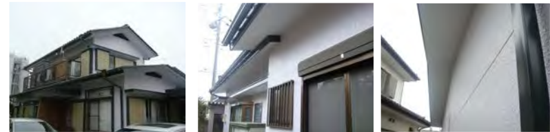
下屋の妻（東側）にも換気口は造られていたが西側には換気口がない。北側、西側の軒天にも換気口はなく、白色腐朽菌の原因は通気性がないためと思われる。
