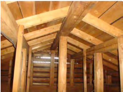
小屋裏の状態はとてもよく、妻の換気口から光が入る
