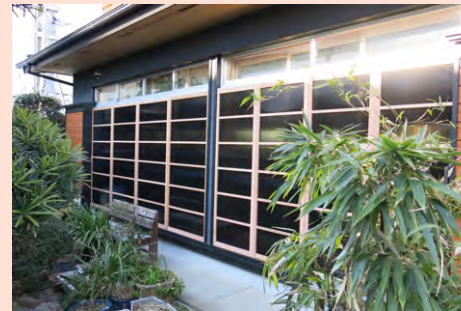
写10 断熱雨戸を閉めた状態（断熱雨戸を閉めても欄間は開放できる）
