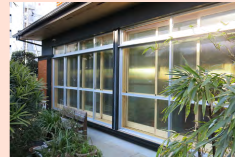
写9 断熱内窓だけを閉めた状態（断熱内窓は中空板なので中はぼんやりとしかみえない）
