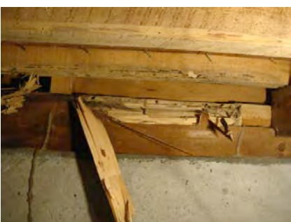
幾つもの蟻道が大引や土台に絡まっている。その中でもみるからに太い蟻道のある土台を石ころを拾って叩いてみると穴が空いて、スカスカ状態の中がみえた
