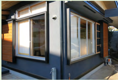
写6 既設アルミサッシだけの状態
