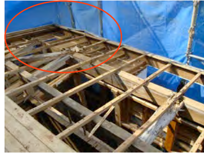
下屋の妻（東側）にも換気口は造られていたが西側には換気口がない。北側、西側の軒天にも換気口はなく、白色腐朽菌の原因は通気性がないためと思われる。
