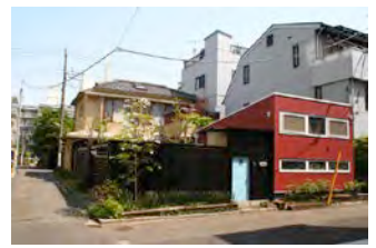
南雄三宅 築70年の古住宅をパッシブリフォームし、Q値2.7まで断熱性を高めた
