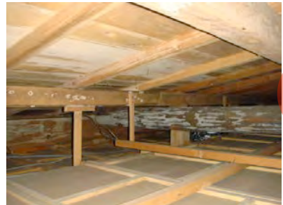
下屋の屋根は金属製の瓦棒葺きだが、母屋、桁、野地板に白色腐朽菌がみえる
