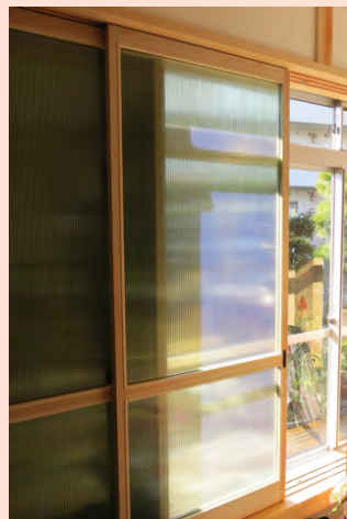
写11 断熱内窓は欄間の上まで閉まる。 冬は閉め、夏の通風時は閉めない
