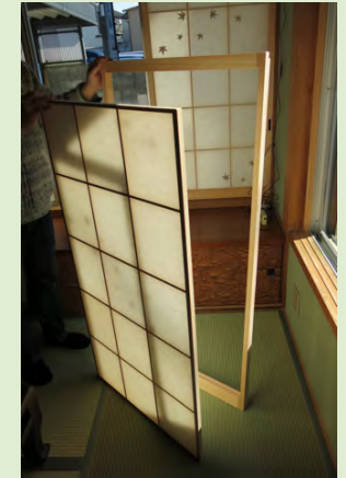
写8 断熱障子は取り外しが可能
