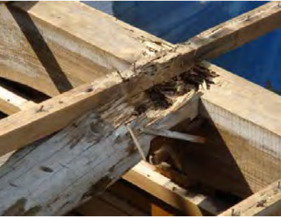
下屋の妻（東側）にも換気口は造られていたが西側には換気口がない。北側、西側の軒天にも換気口はなく、白色腐朽菌の原因は通気性がないためと思われる。
