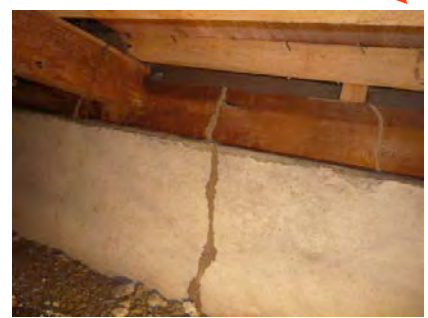
幾つもの蟻道が大引や土台に絡まっている。その中でもみるからに太い蟻道のある土台を石ころを拾って叩いてみると穴が空いて、スカスカ状態の中がみえた
