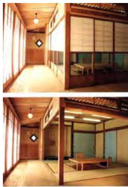
写真は拙宅の縁側と座敷です。縁側の熱的クッション効果を表面温度計で計測しました。冬の午後11時半（及び午前7時）に、木製サッシ・複層ガラス窓の室内側表面温度は13°C程度ですが、障子面では17-18（15-16）°Cに改善し、座敷の障子面は座敷の温度と同じです。また、縁側床表面は外部に近い処では18（16）°Cですが、座敷に近い処では20（17）°Cになっています。つまり、縁側の1.5mの幅の中で、窓による冷気の影響は消滅しているのです。
