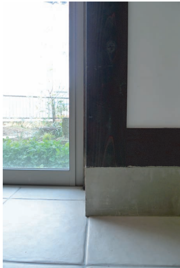
土台、基礎を表すことによって、木を健全に保つと共に不具合の発見、メンテナンスが容易に出来る。
