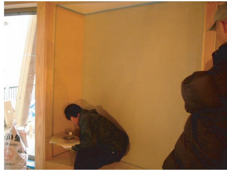
⑤ 仕上は自然素材にこだわる。和室の床の間は酸化黄を混ぜた黄色いしっくい。 (左官屋さん出来栄を確かめる設計者。)
