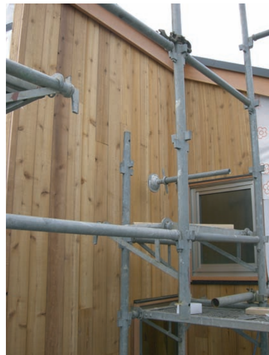
外壁は防火性能を付加した板張り、付加していないものに比べ耐久性、防汚性能に優れている。
