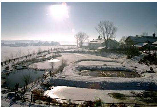
動物から出た糞尿やゴミからバイオガス（メタンガス）をとって発電している。灯油換算で200～250リットル/日分を発電し農場内の電力を賅なえる。糞尿は数段階の汚水処理を経て最終的には便所と植栽の水に再利用されている。
