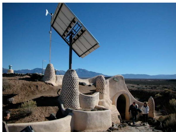
空き缶、空き瓶が壁の装飾になる。風力発電、太陽光発電、太陽熱給湯でエネルギーの自立を図る。
