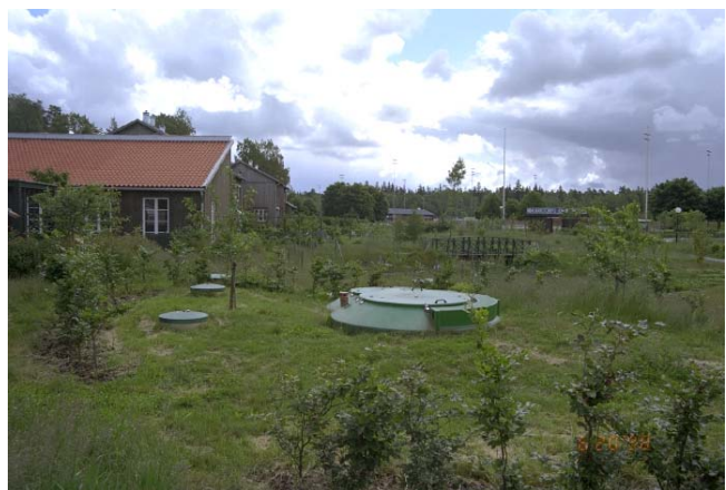
汚水を浄化する装置
