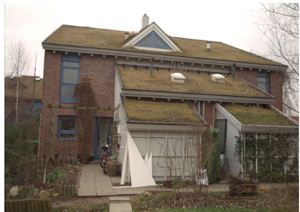
屋根緑化、壁面緑化
