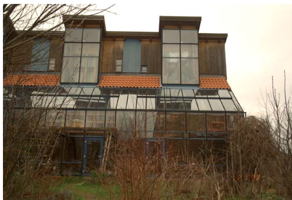
煙突状の開口部はパッシブの装置
